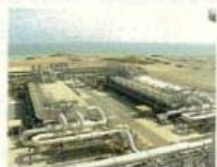
海水淡水化プラント建設
