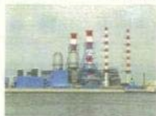
火力発電所建設
